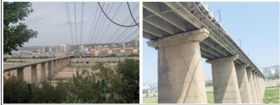
图 3-1 原铔山大桥现状
