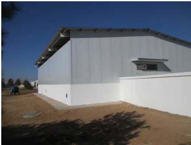
危废暂存库整体
