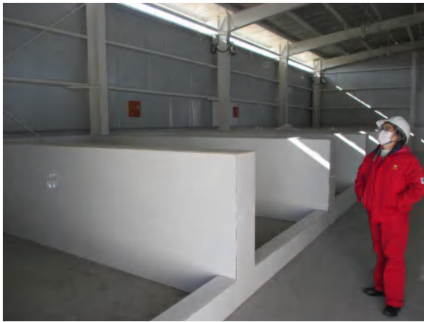
危废库内部左侧分区
