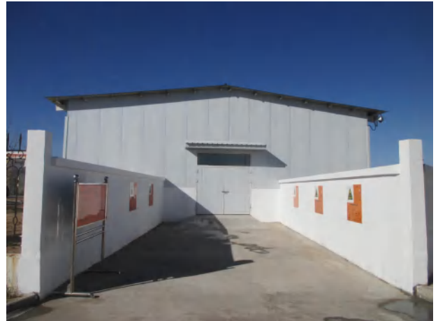
危废暂存库入口
