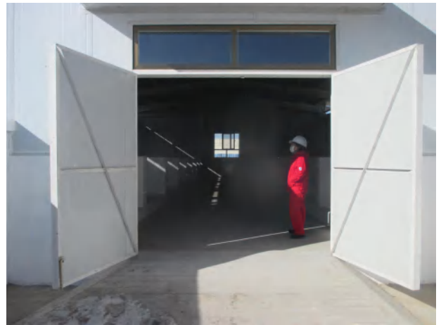
危废暂存库内部
