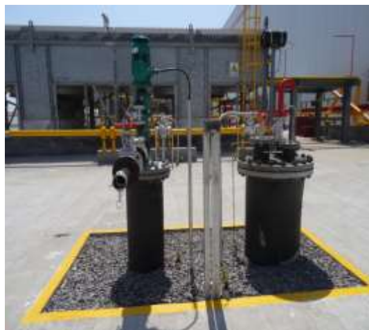
图 3.1-3 现有废机油罐区
