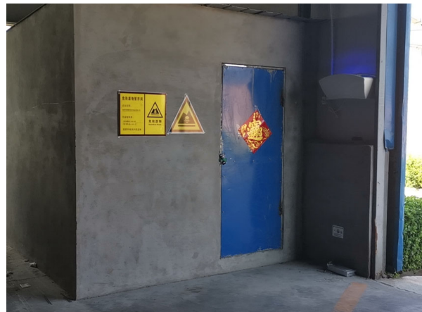
危险废物暂存间
